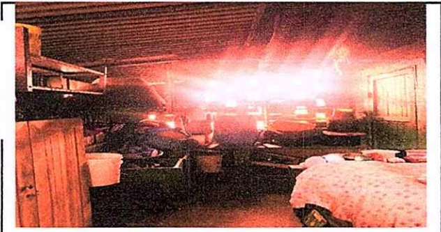
FOTO 1: ESTADO ACTUAL COCINA MAL ESTADO
